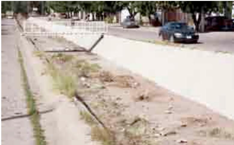
Tras más de dos años de gestiones, el Gobierno de Sinaloa instaló un barandal de protección en el canal de la colonia Santa Fe.
